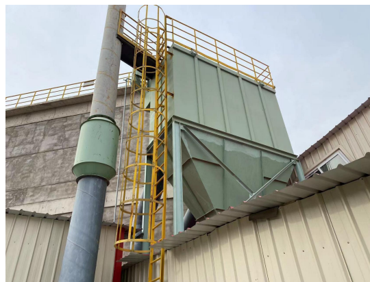
出一级破碎机皮带收尘器
